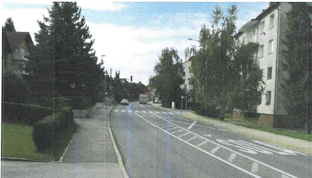
Slika 18: Na Cesti Miloša Zidanška in Ulici Dušana Kvedra so prometne površine pešcev ustrezno urejene
