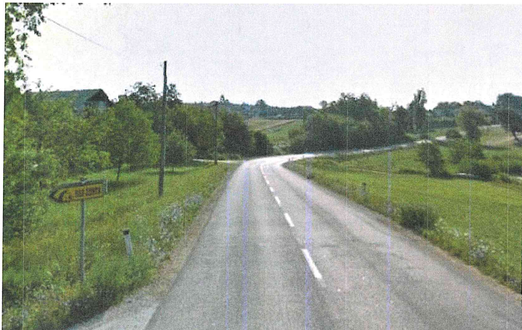
Slika 27: Cesta skozi Goričico brez urejenih površin za pešce
