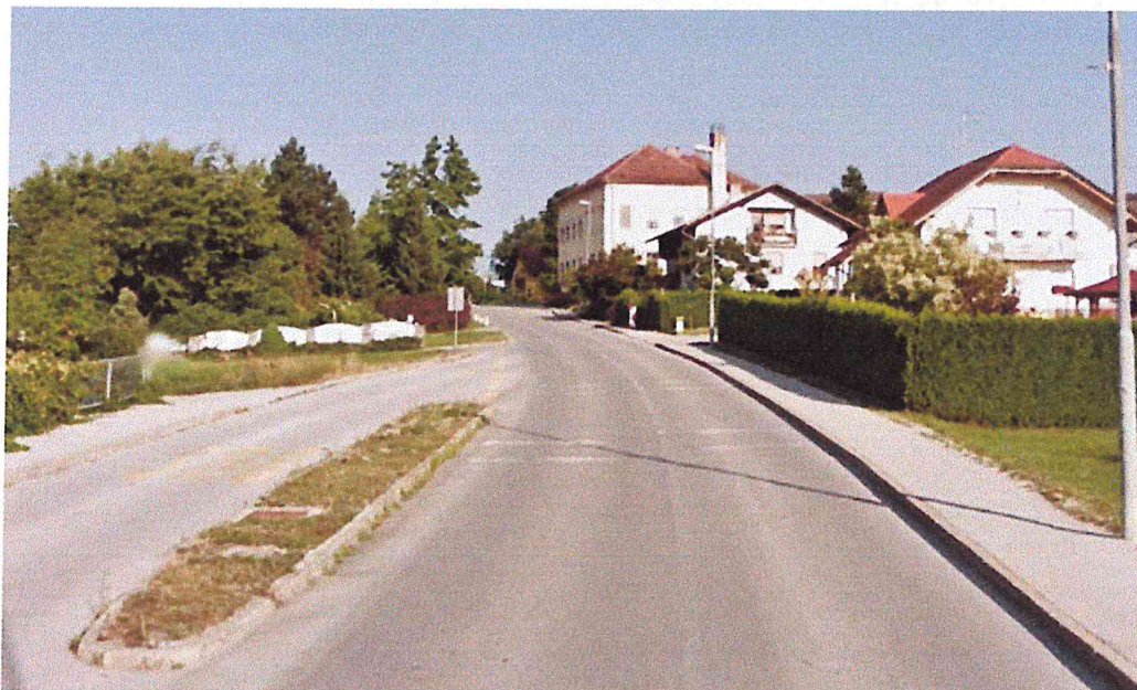
Slika 176: Urejene površine za pešce na cesti skozi Proseniško
